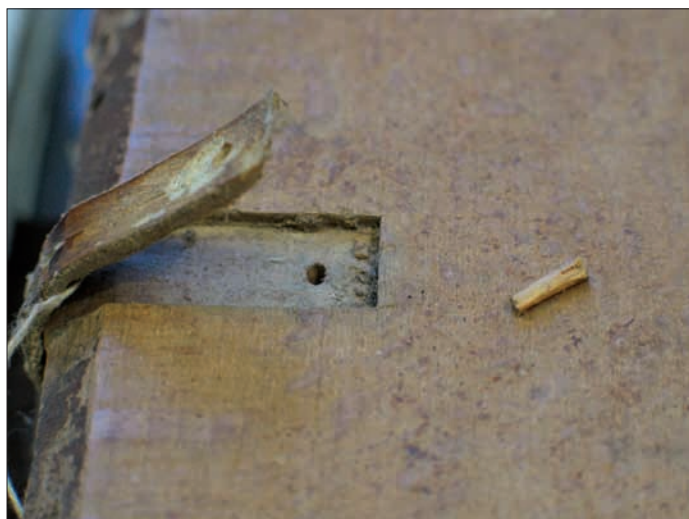
60. ábra A táblák lebontása, a faszög eltávolítása után
