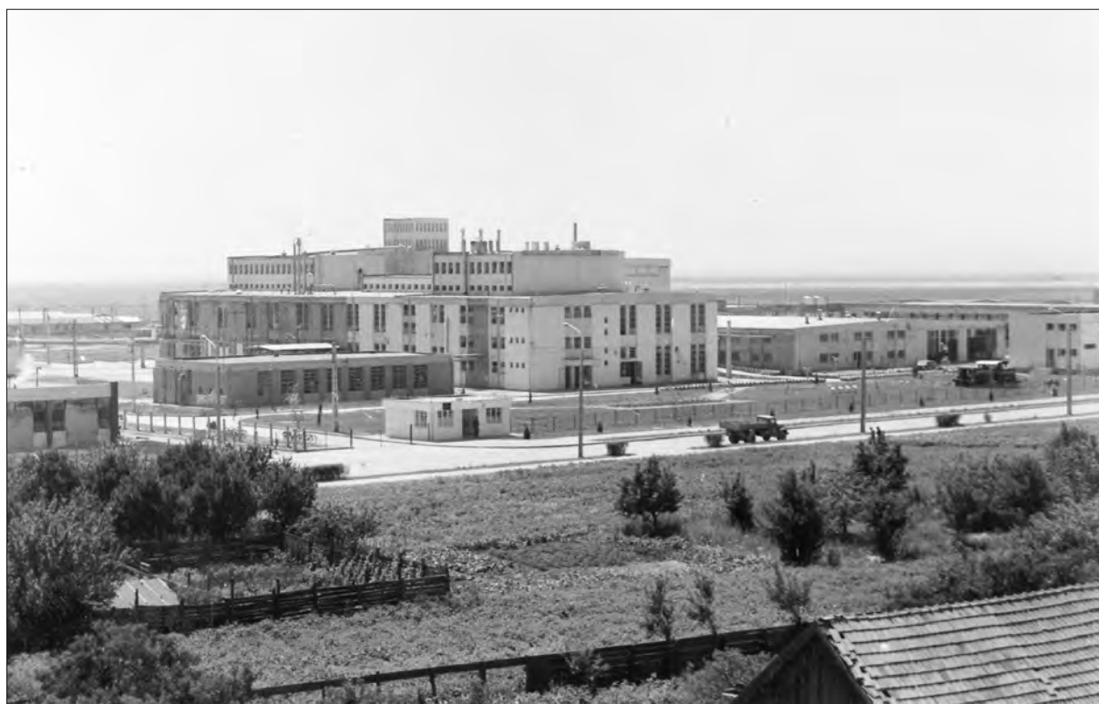
49. ábra Kézdivásárhely épülő ipari övezete, a glükózzgár – ILCM fotótár
